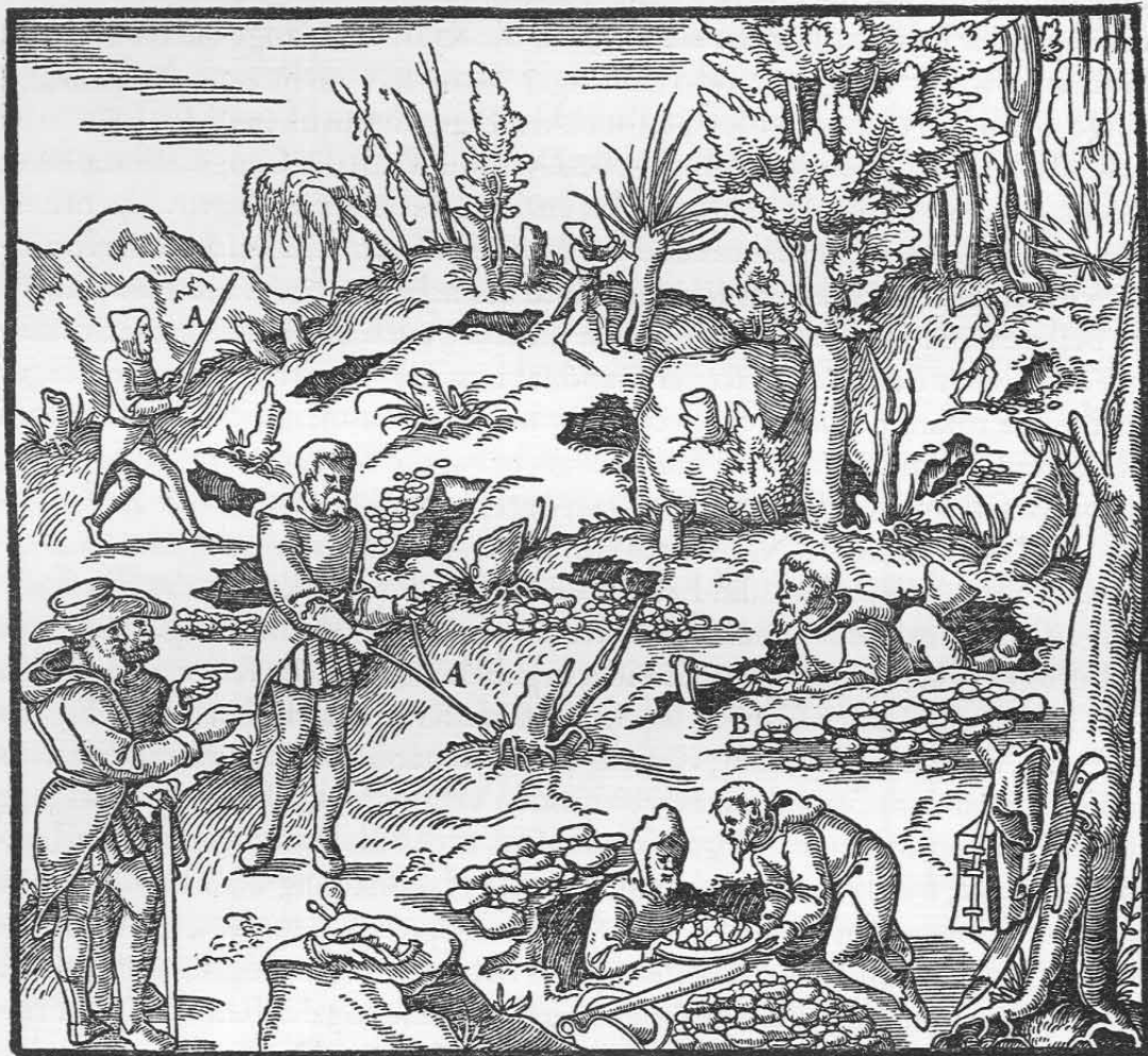
Auffuchen der Gänge mit der Wünschelrute und durch Schürfgräben. Die Wünschelrute A. Ein Schürfgraben B.
