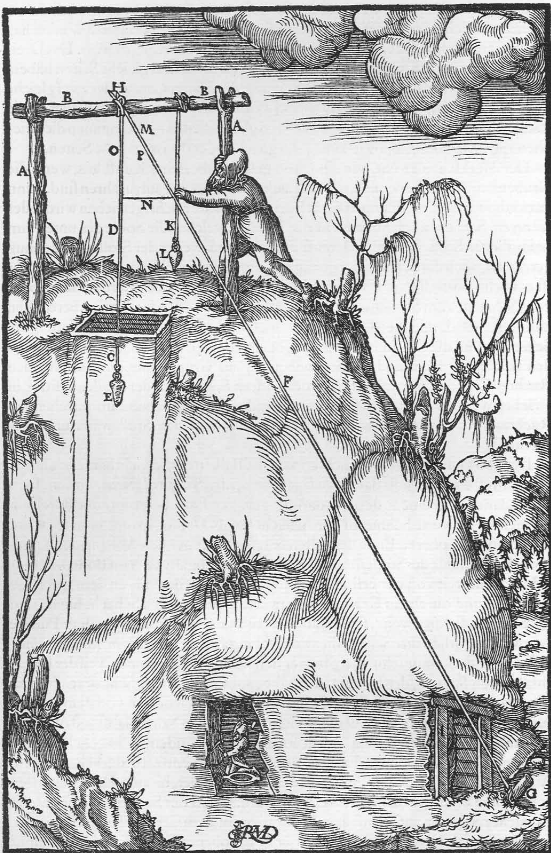
Das Joch A. Das Querholz B. Der Schacht C. Die erste Schnur D. Das Gewicht der ersten Schnur E. Die zweite Schnur F. Ihre Befestigung im Boden G. Der Anfang der ersten Schnur H. Das Stollenmundloch I. Die dritte Schnur K. Das Gewicht der dritten Schnur L. Das erste Maß M. Das zweite Maß N. Das dritte Maß O. Das Dreieck P.
