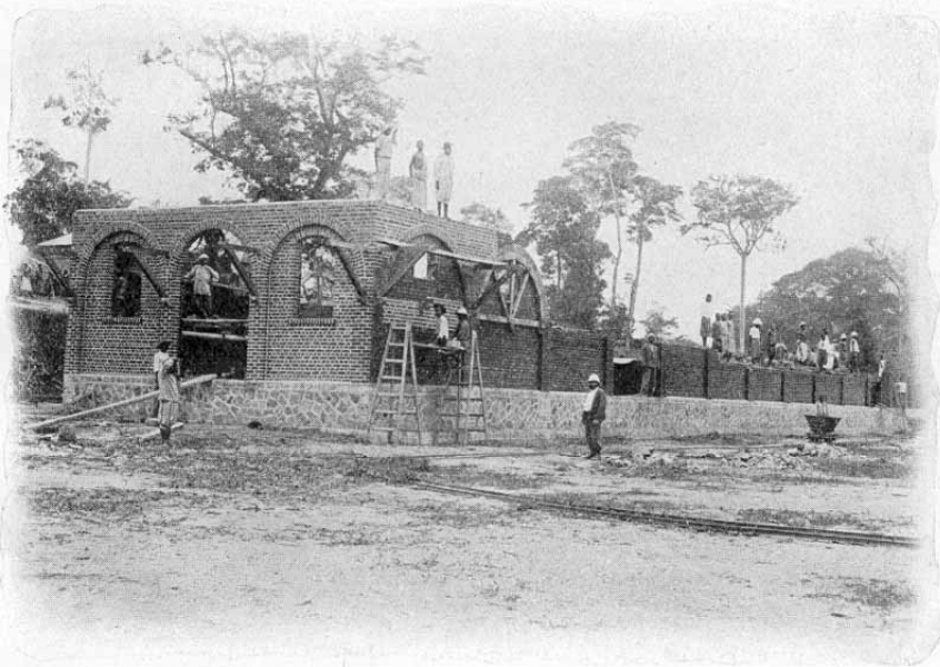
Stanleyville. — Bau eines Magazins.
