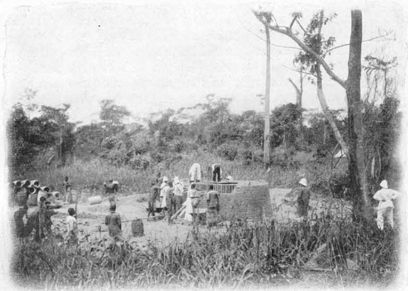
Bau eines Kalkofens in Stanleyville.
