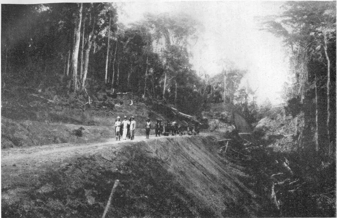
Erdarbeiten bei km 117—118.
