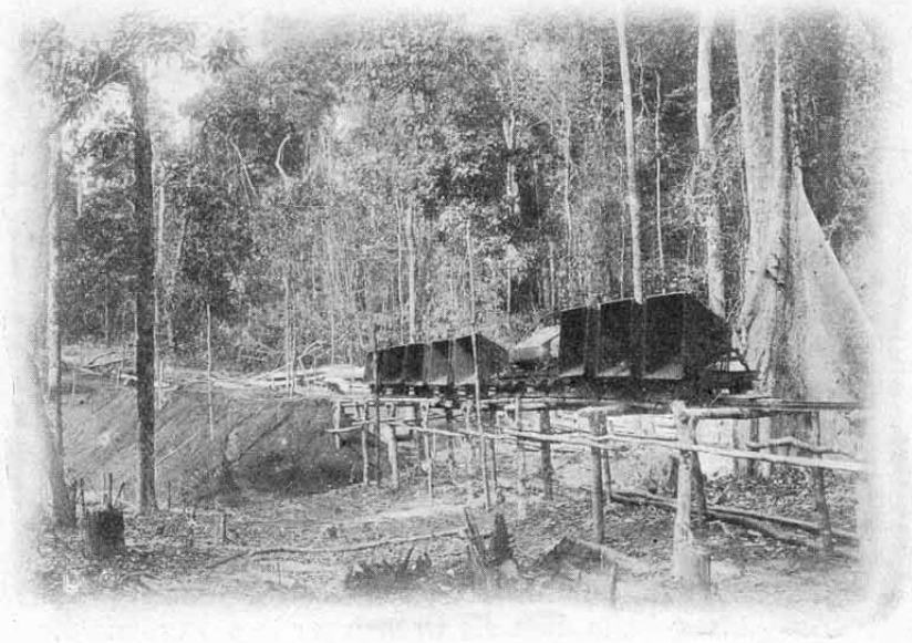
Dammbau bei km 77.
