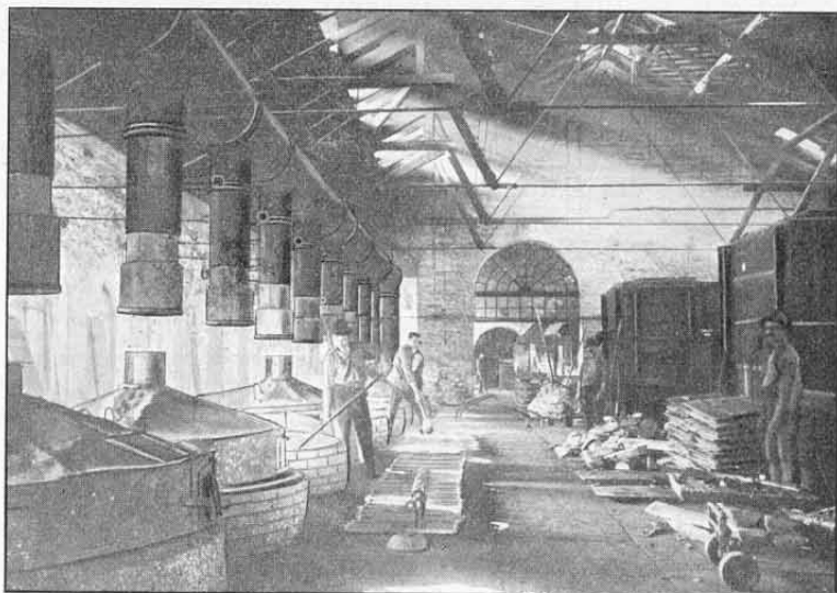
Fig. 58. Ausgießen des Bleies zu Barren.
